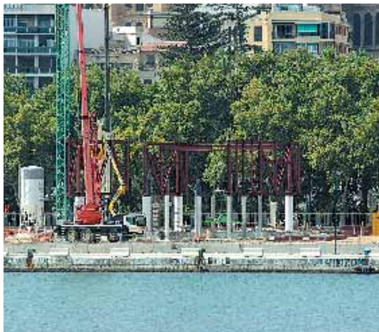
BAU. Die Arbeiten sind in vollem Gange. / SUR
